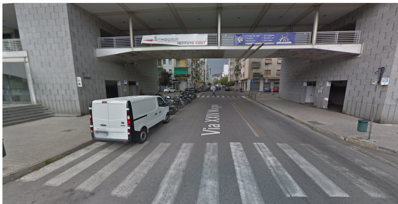
Foto 3 - Tratto filoviario in esercizio sotto passerella pedonale in Via XXIV Maggio in corrispondenza di Piazzale Kennedy alla SPEZIA (si vede lastra isolante sotto passerella pedonale e canale di protezione dei 2 fili di contatto del bifilare)
